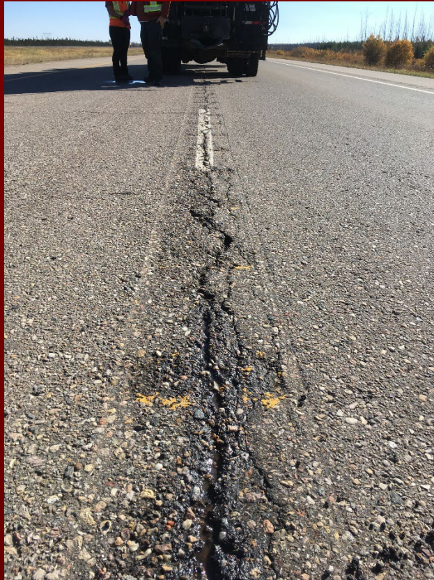
Longitudinal Crack
